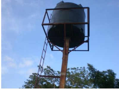
Depósito elevado de água para a maternidade
